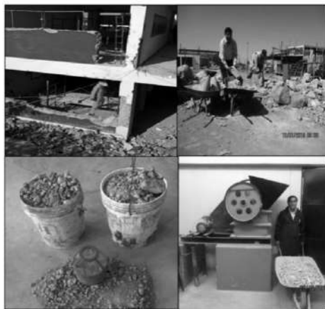
Figura N.º 12. Obtención de agregado grueso reciclado de escombros de la CU UNJBG
